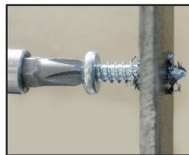
Presione con fuerza y atornille con velocidad lenta hasta que la punta del tornillo penetre. Esto evita que el tornillo resbale.
