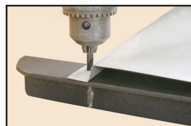
Realice perforación al material a fijar.
