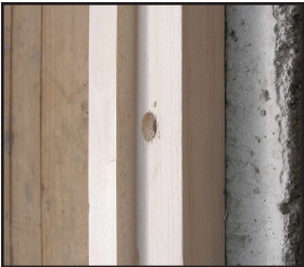
Termino del Avellanado para fijar el tarugo.
