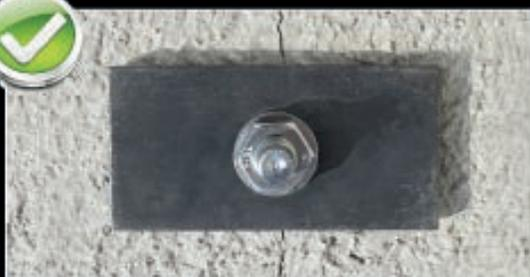
Ejemplo de aplicación en hormigón fisurado.
