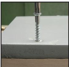
Fijar tornillo con atornillador phillips o pozidrive.
